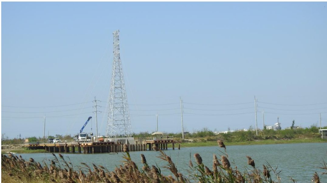
圖五十四、下半年電塔復建情況，圖為尚未拉起高壓電線前的情況
