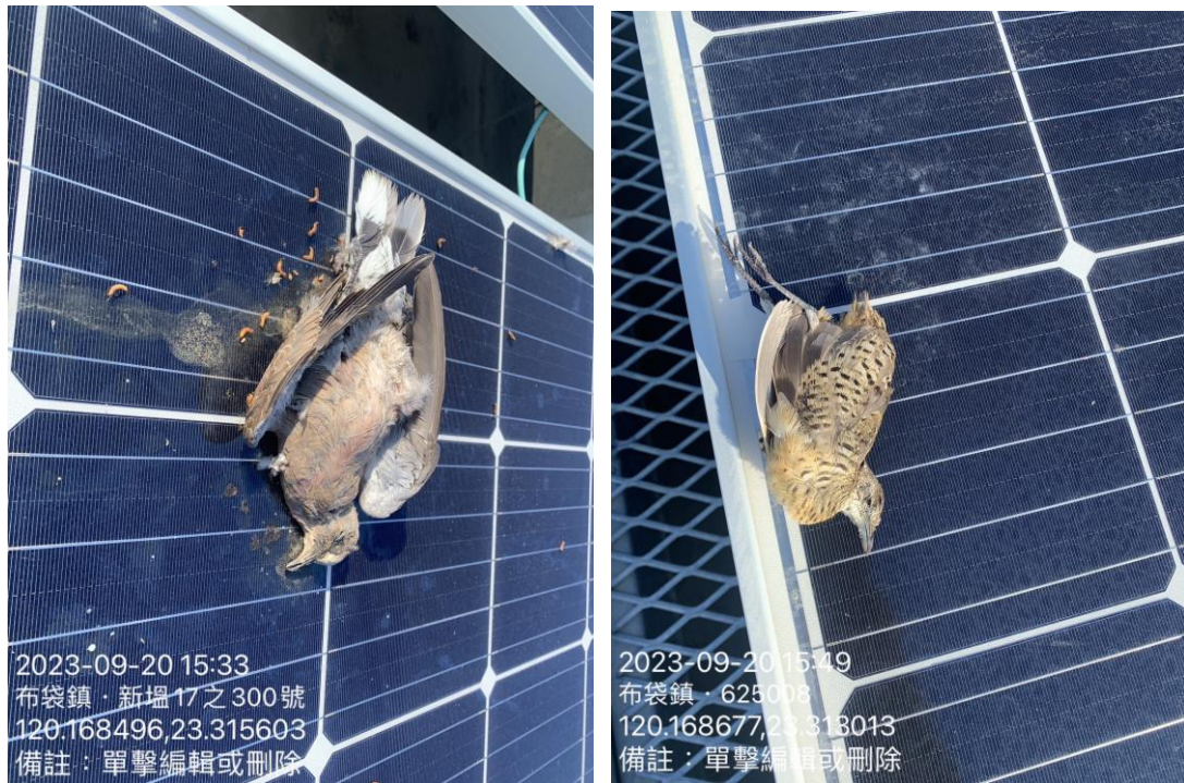
圖五十四、寶島駐場工程師協助清除光電板上死亡個體照片
