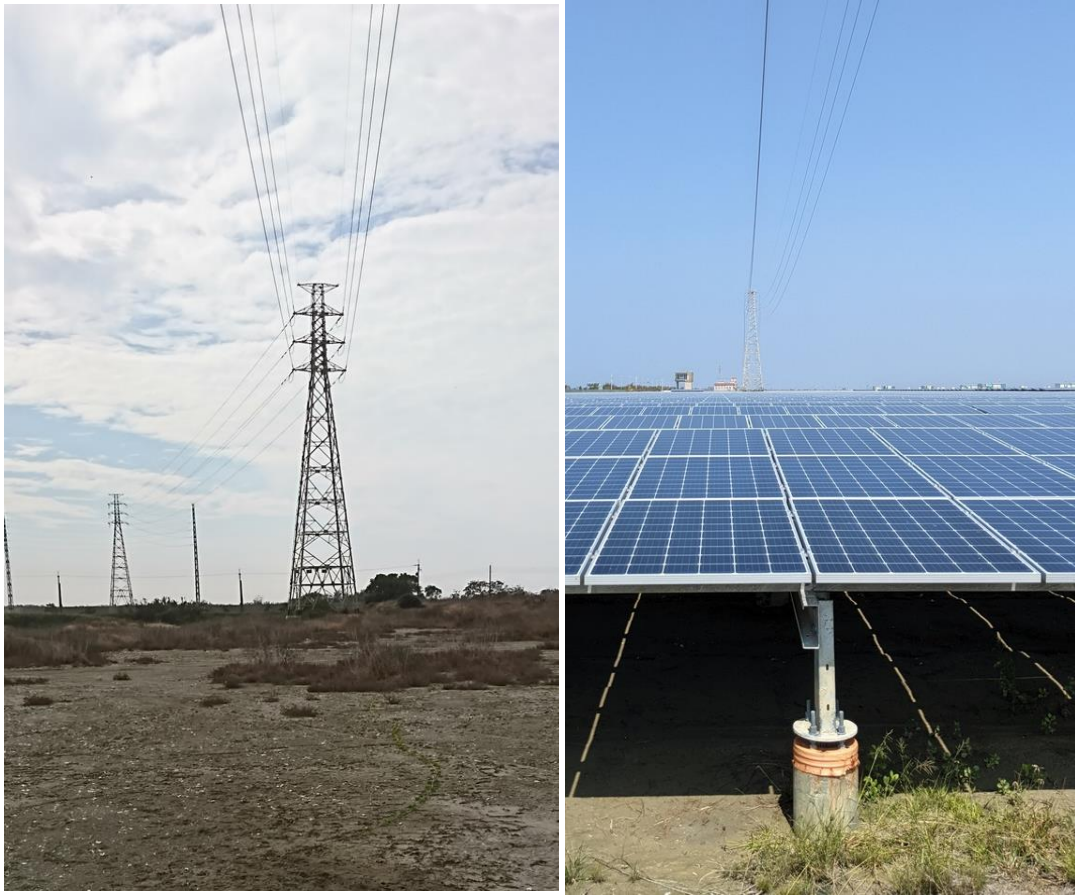
圖五十二、跨越案場區西側的高壓電塔施工前後圖
